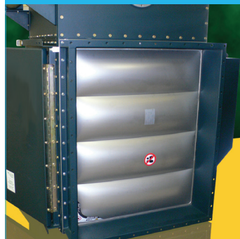
Válvula anti-retorno de explosiones
