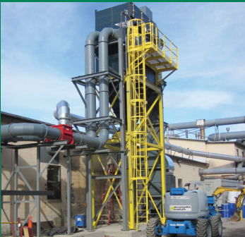
Intercambiador de calor de los gases de impulsión que no pueden ser recirculados
